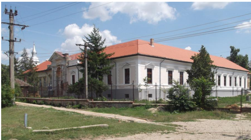
A felújítás alatt álló Zichy-kastély.
