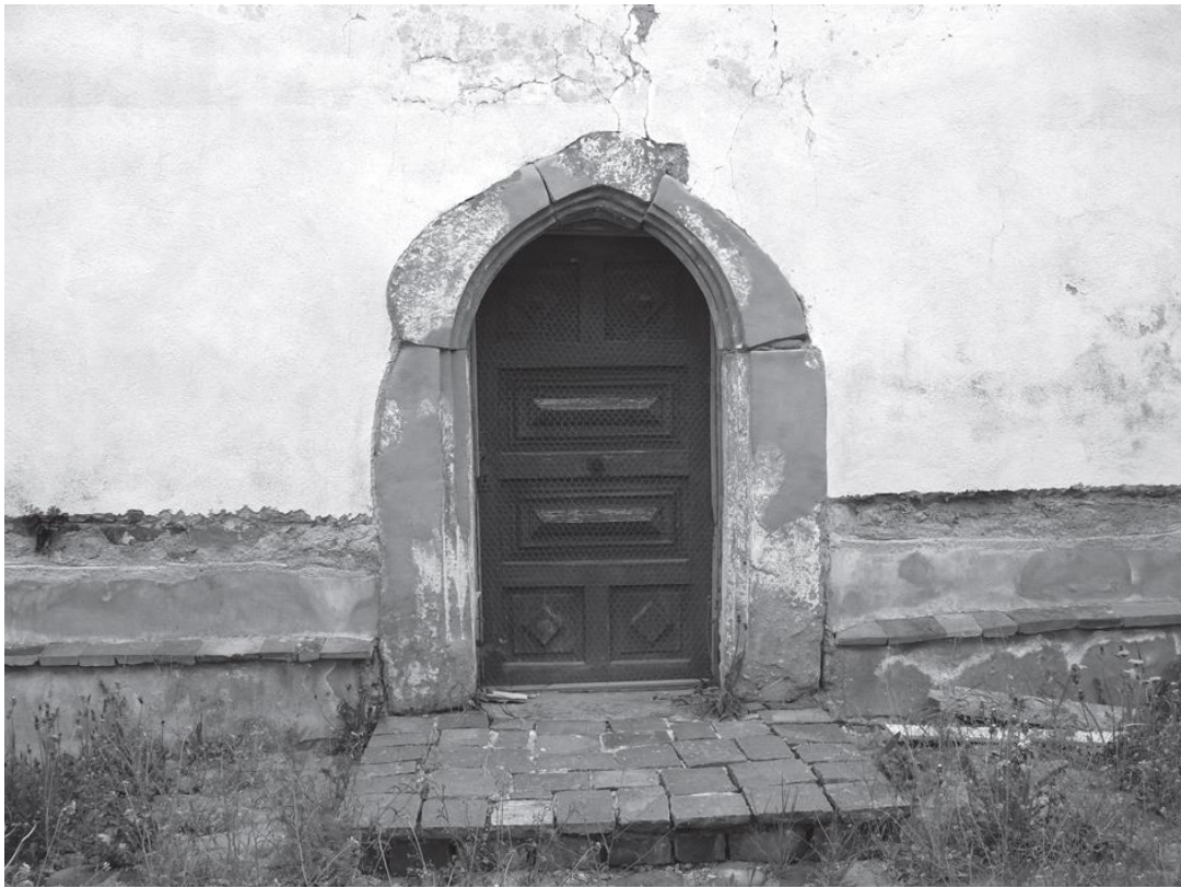
11. ábra A nyugati homlokzat csúcsíves ajtókerete és az új kőlapos burkolat.
